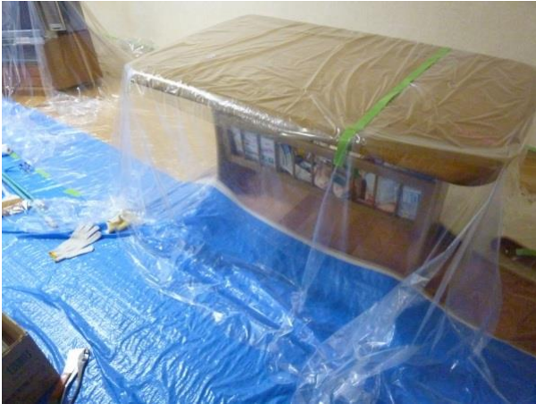
① ものを塗料の飛散から守る養生
