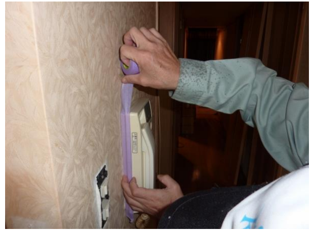
② 塗装の線をまっすぐに仕上げる養生
